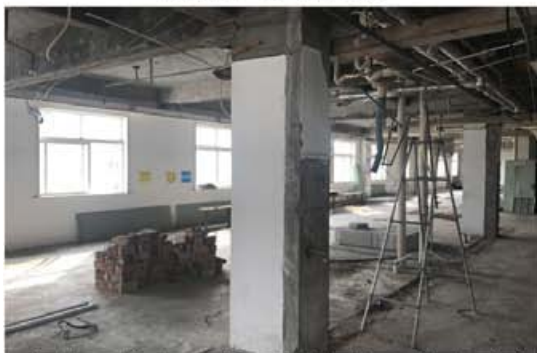
南侧：综合大楼五层过道及拟建病房
